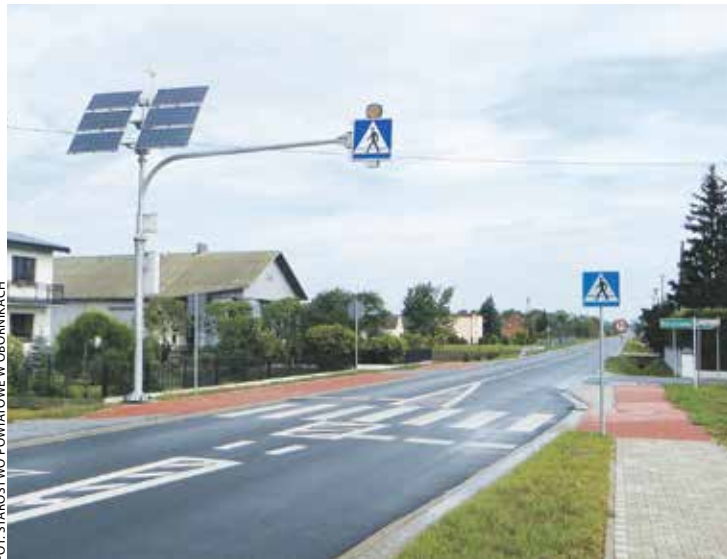
Przebudowana droga Ludomy – Ryczywół (powiat obornicki) na odcinku Ludomy – Gorzewo, dofinansowana z PROW.
