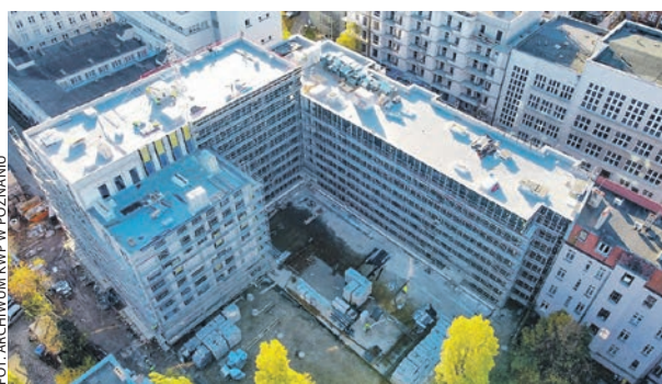
Nowe laboratorium powstaje na poznańskich Jeżycach.
