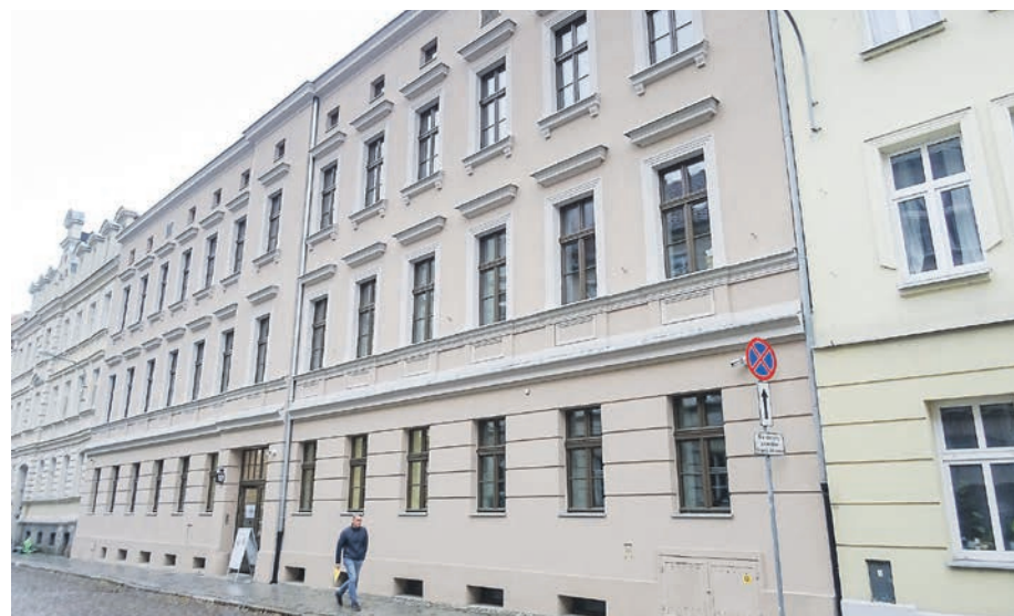
W ramach projektu odrestaurowano fasadę kamienicy przy ul. Grobla.
