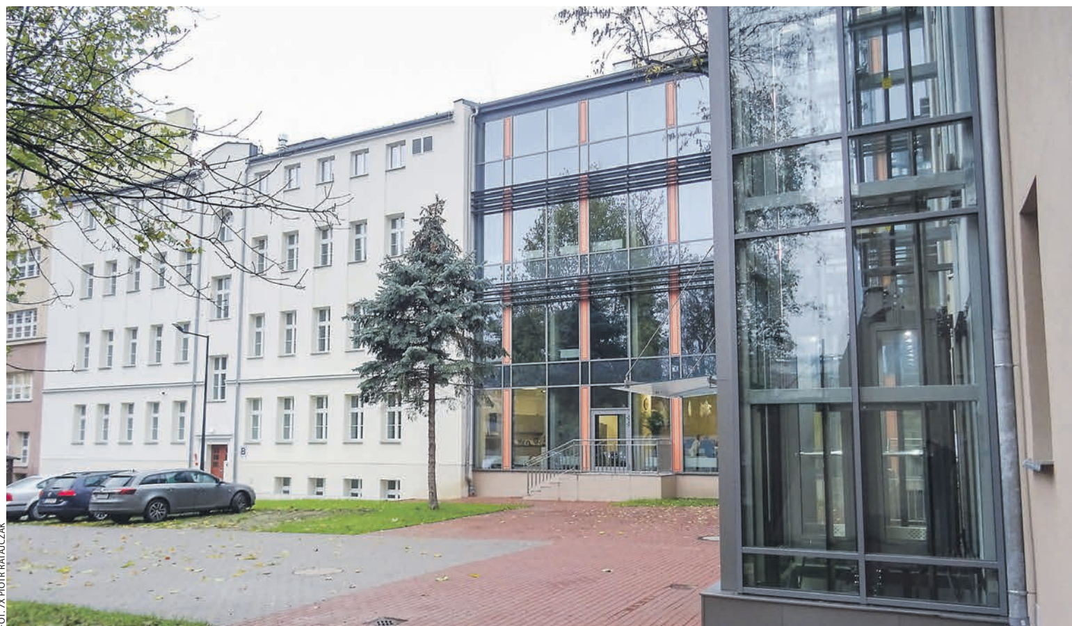
W kompleksie WSKZiU nr 2 pomiędzy ul. Mostową 6 a wyremontowanym budynkiem przy ul. Grobla 26 powstał nowy szklany łącznik.
